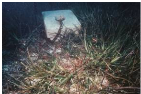
Figure 2 (ci-dessous) : Exemple de dégradation de l'herbier à Posidonia oceanica occasionné par l'évitement de la chaîne du corps-mort servant à baliser la zone des 300 m. Photo F. Bachet/PMCB.
